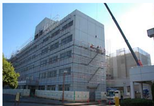
改修工事中の 1・2 号館
